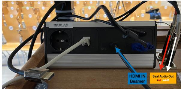
Die beiden Audio Stecker der Saalanlage ersetzen durch eigenes Cinchkabel. Das andere Ende in die beiden Audio Kanäle der Pearl stecken. RCA/Cinchkabel im Pearl Koffer. Nach der Aufnahme Saalkabel **UNBEDINGT** wieder zurückstecken.
